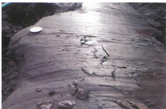
Obr. 5: Ohlazy na smykové ploše v podložních během přípravných zemních prací. [13]
